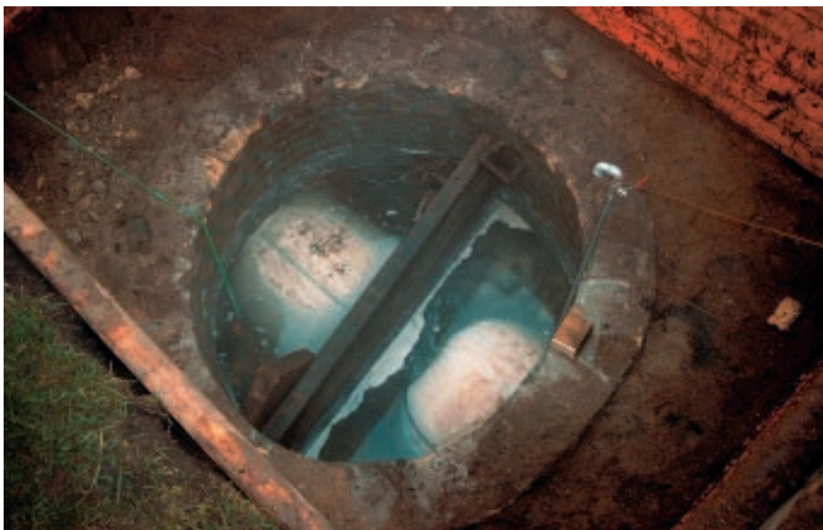
Zwei Linerenden der Eversionsstrecke 380m DN 800 und 270m DN 700 stoßen in Präzisionsarbeit genau in einem Zwischenschacht aufeinander.
