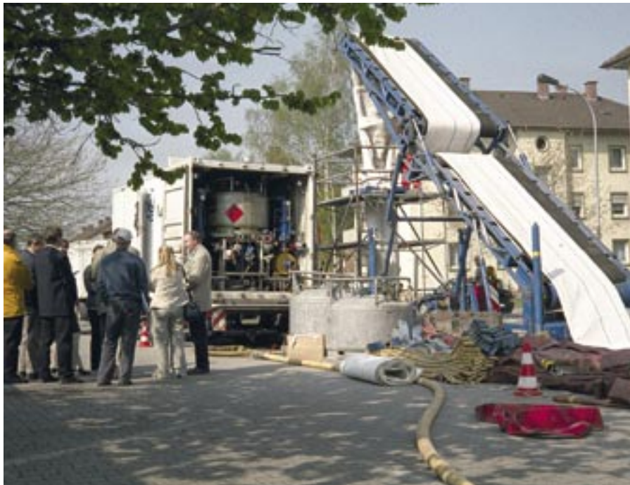
Inversion des Insituformschlauches mit dem Förderband
