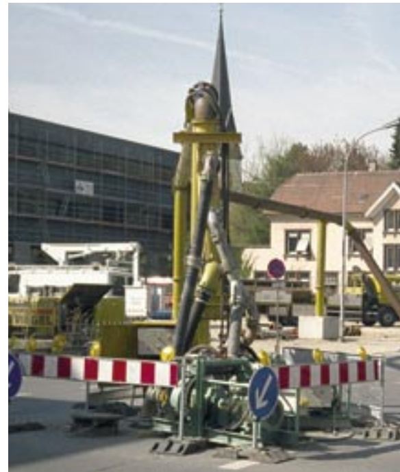
Rohrbrücke der Wasserhaltung
