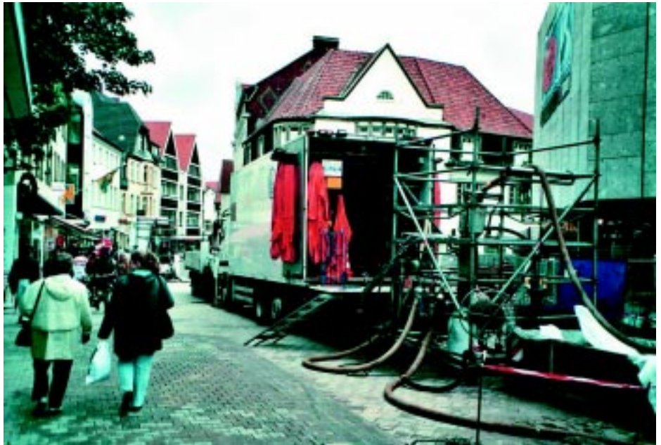
Blick auf die Insituform CHIP-Unit in der Soester Altstadt
