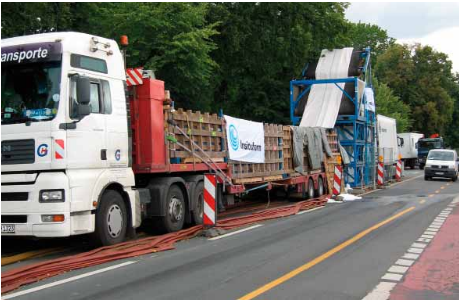
Direkt vom Tieflader wird der Schlauch mit einem Gesamtgewicht von rund 22 Tonnen in den 210 Meter langen Haltungsabschnitt invertiert.
