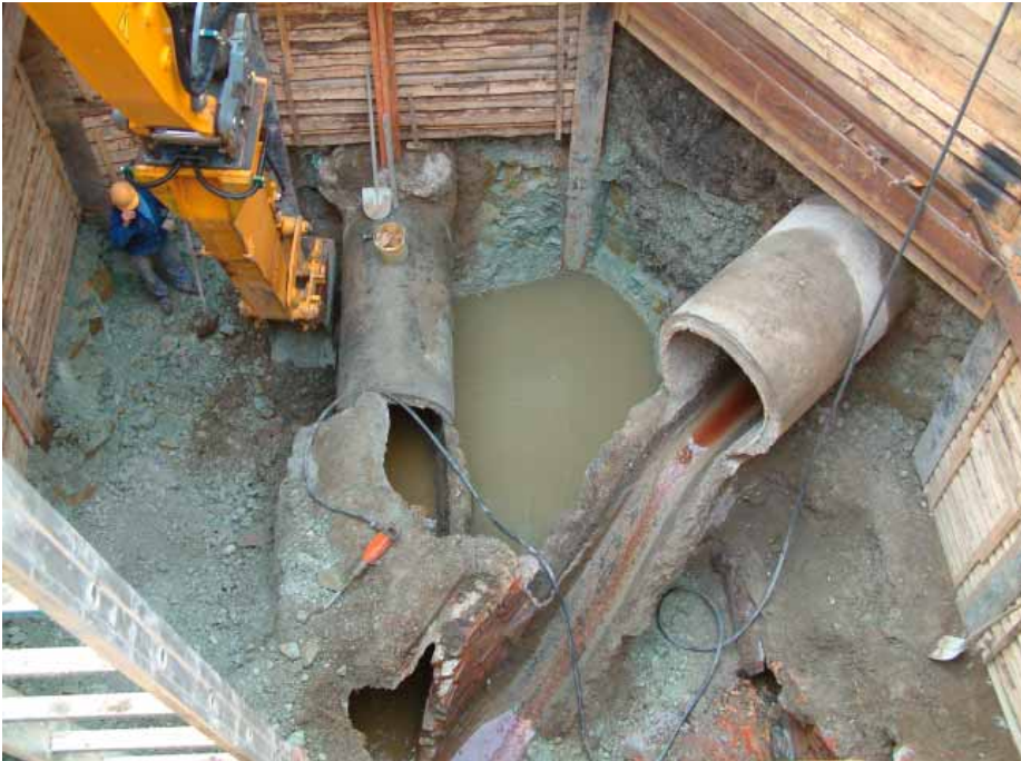
Freigelegt: Das Kreuzungsbauwerk in 9 Meter Tiefe. | Fotos: A.E.
