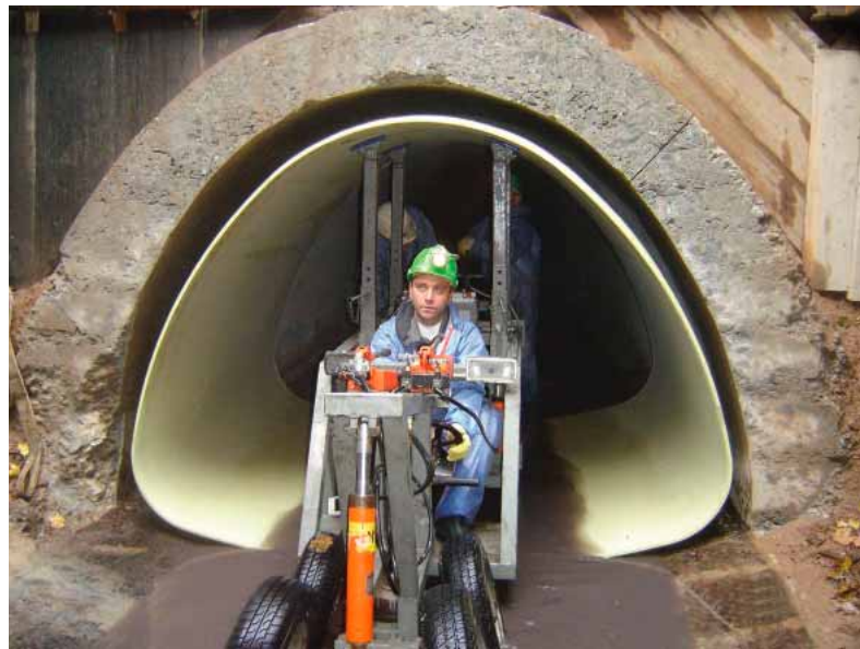
...und mit einem speziellen Wagen zum Einbauort transportiert.
