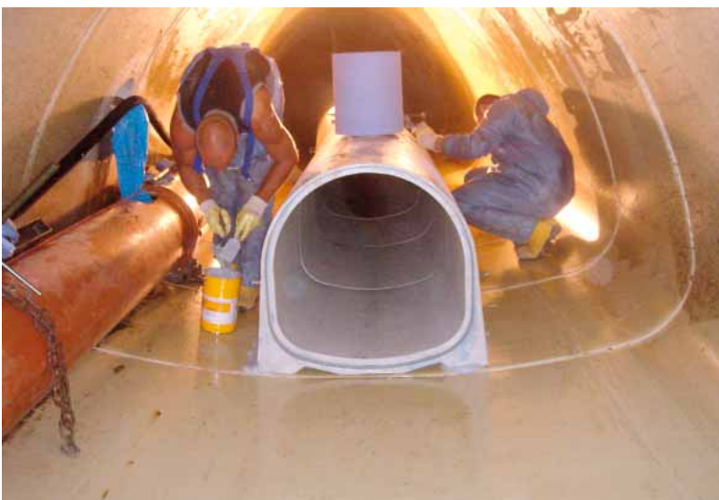
Die Verklebung der Stollenteile erfolgte auf den gereinigten GFK-Elementen mit einem Epoxydharzkleber.
