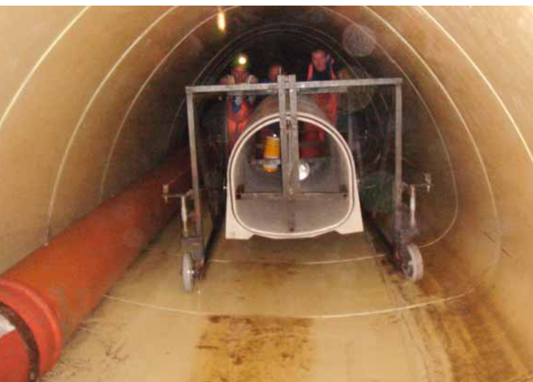
Auch die Polymerbeton-Elemente wurden mit einem speziellen Fahrwagen zum Einbauort transportiert.
