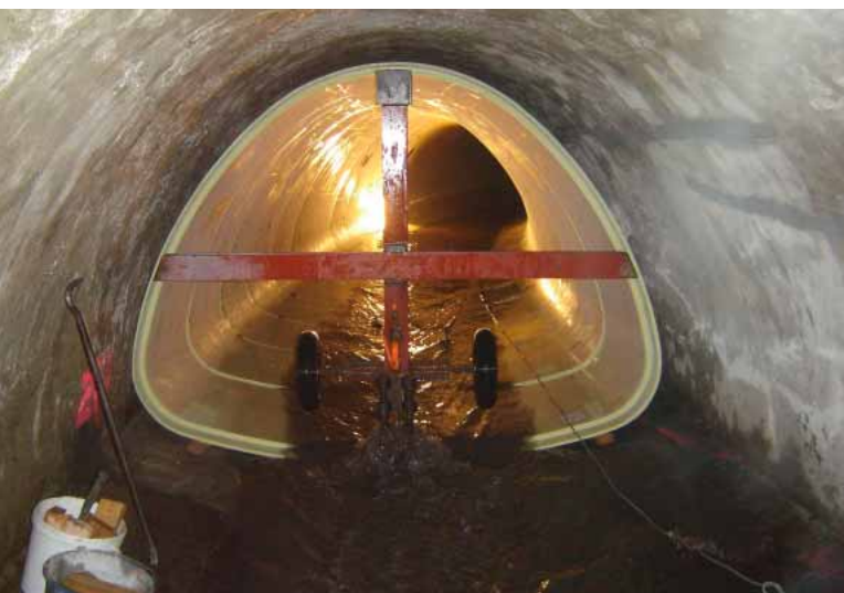
Die Elemente wurden mit Hilfe eines Ziehkreuzes und einer 10t - Seilwinde zusammgezogen.
