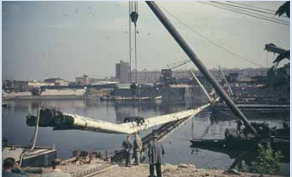
Einschwimmen der Dükerleitungen 1956
