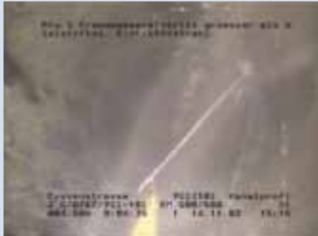
Dükerleitung vor der Sanierung
