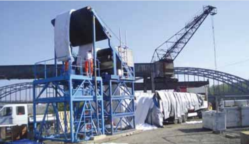
Inversion des Schlauchliners DN 900
