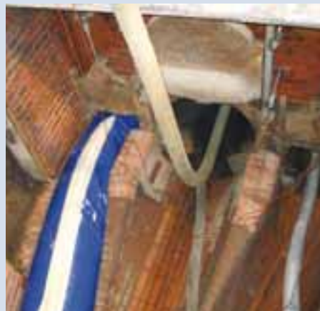
Inversion des Schlauchliners DN 500 im Dükeroberhaupt
