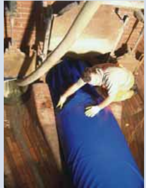
Inversion des Schlauchliners DN 900 im Dükeroberhaupt
