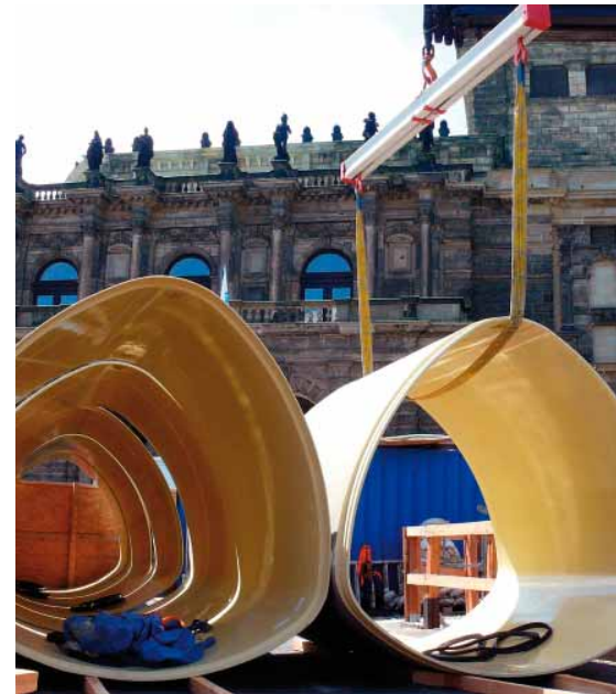
Installation eines GFK-Elements unmittelbar vor der Semperoper.
