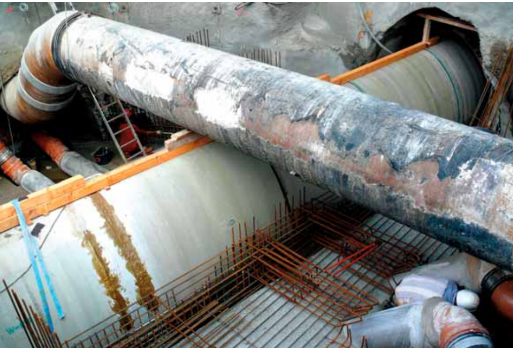
Bauwerks- und Einziehgrube unterhalb der Carolabrücke, mit bauzeitlicher Querung eines Entlastungskanals DN 500 einschl. Gewässerquerung Kaitzbach DN 1000 und DN 500 mit Auslass in die Elbe.
