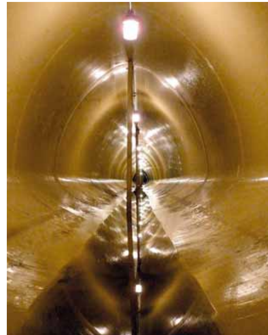
Neues Innenleben für den Altstädter Abfangkanal: GFK-Haubenprofilrohre der Hobas GmbH.
