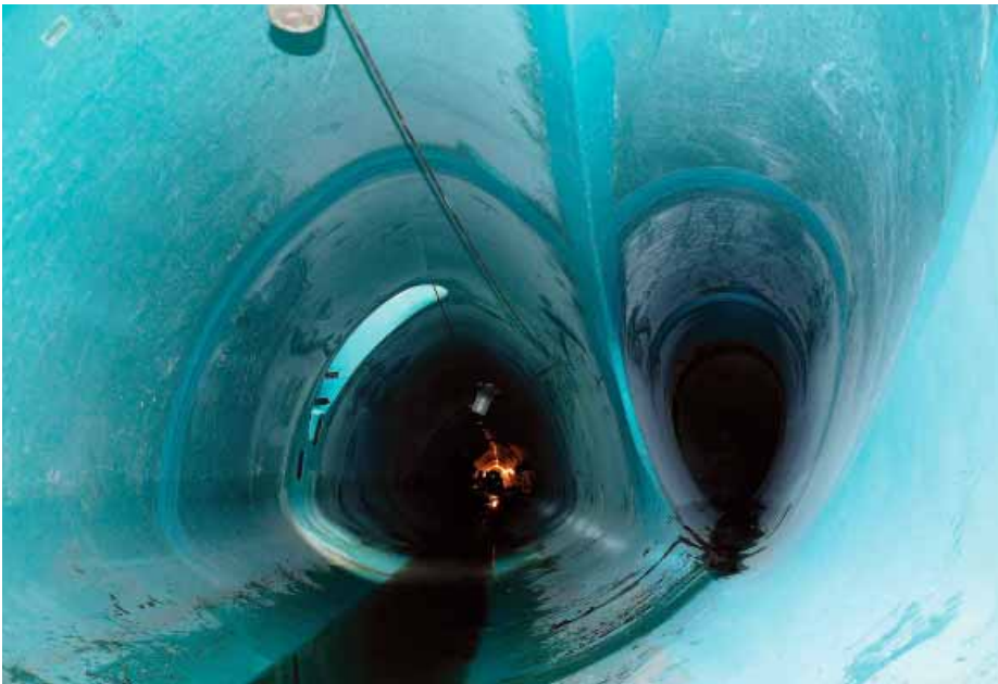
Sonderformteil aus GFK-Wickelrohr von Amitech Germany mit integriertem Zulauf eines Eiprofilkanals 800/1200 mm
