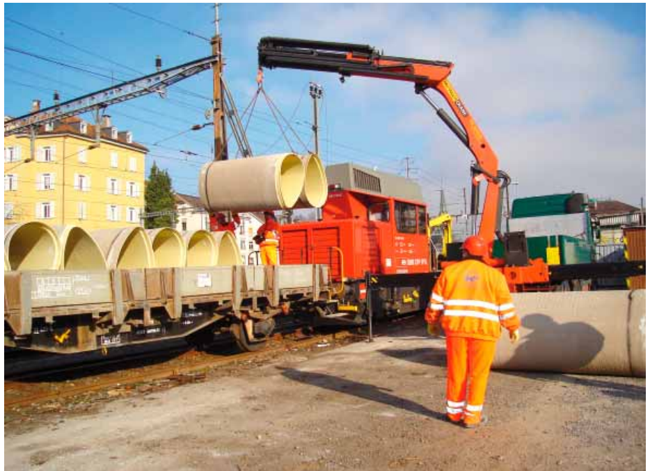
Bahntransport der GFK-Rohre.
