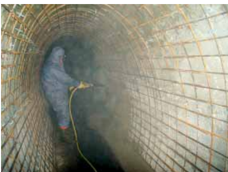
Spritzarbeiten im Nassspritzverfahren.
