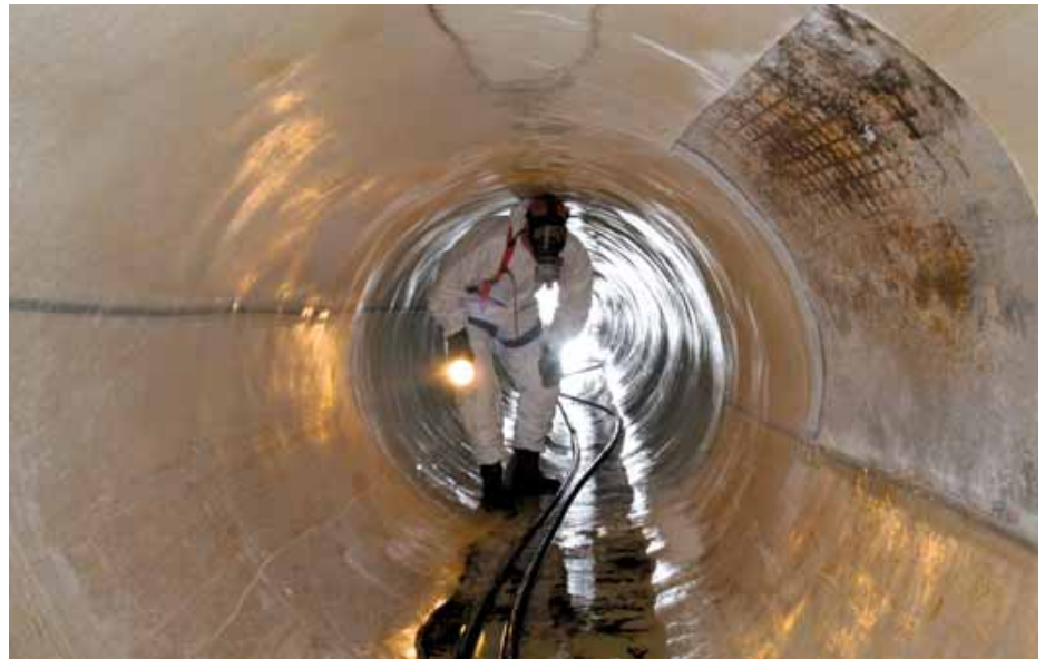
Sanierter Mischwasserhauptsammler DN 1600 in Frankfurt (Oder)
