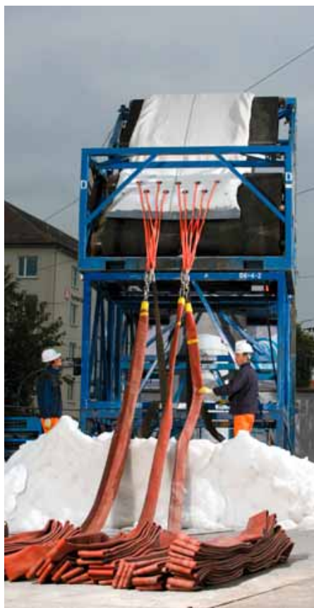
Einzug der Heizschläuche zum Aufheizen des Inversionswassers
