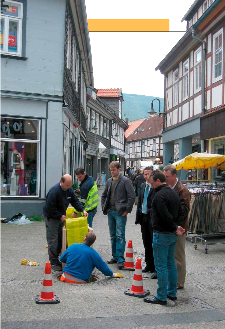
Kaum Behinderungen: Einzug eines 43 Meterlangen Glasfaserliners in die zu sanierende Haltung.
