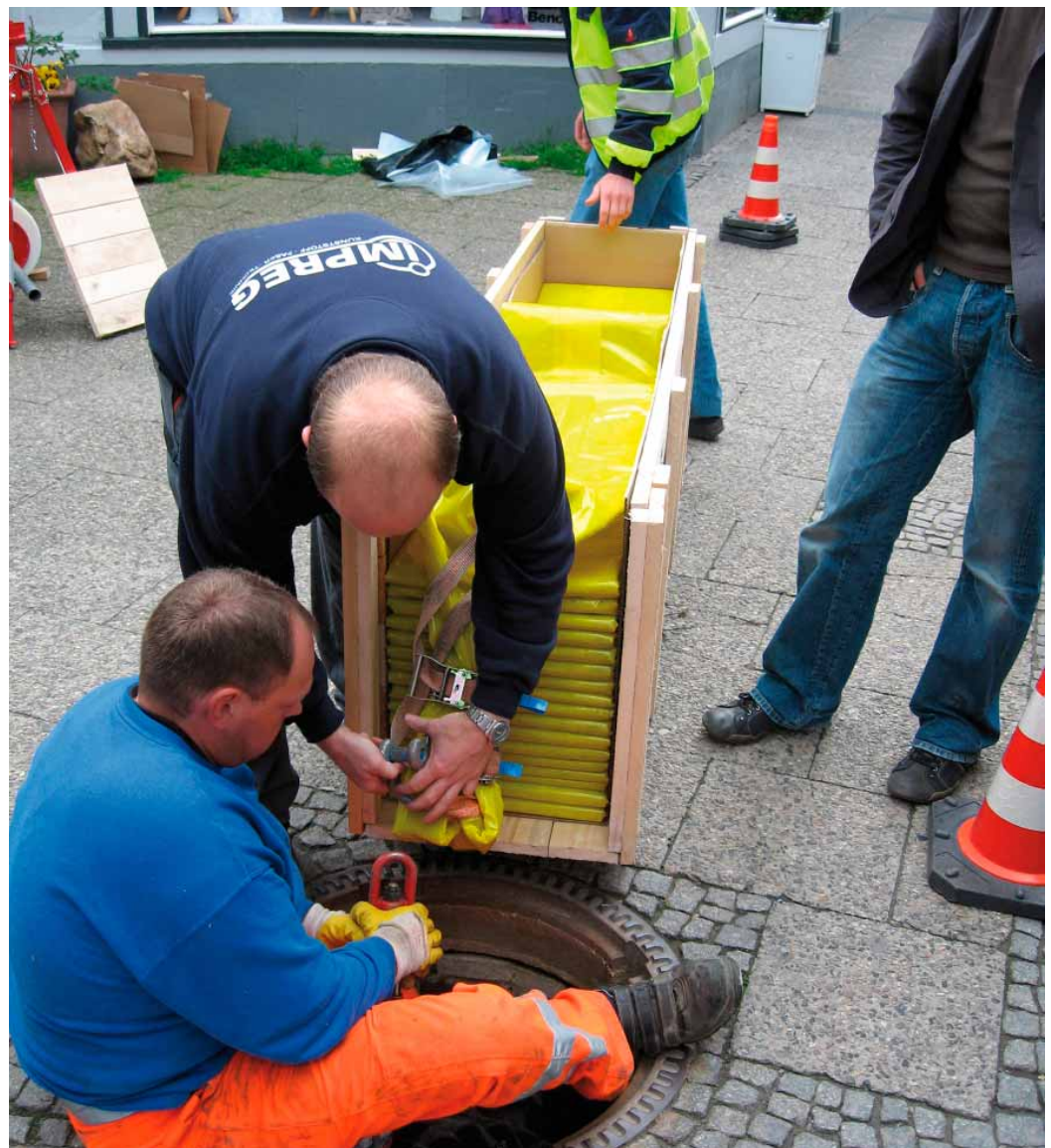
Vorbereitung des Linereinzuges.
