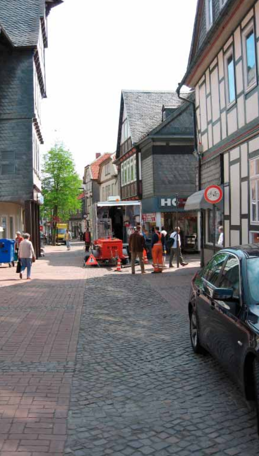
Das neue Sanierungsfahrzeug für Lichthärtung in der Fußgängerzone in Goslar.
