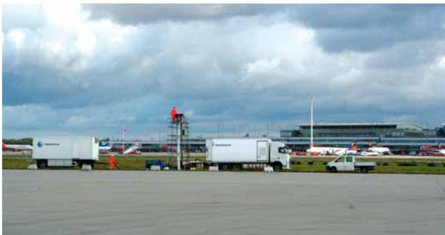
Im Bereich der Vorfelder kam das klassische Insituform-Verfahren mit Warmwasserhärtung zum Einsatz.
