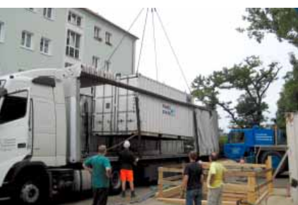
Endladung einer der beiden zusätzlichen mobilen Heizanlagen zur Aushärtung des Liners.
