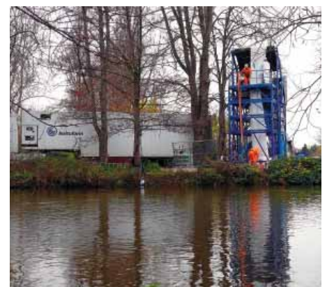
Schlauchliner-Einbau von Düker-Unterhaupt her: Der Inversionsturm mit Inversions-Wassersäule und dem Heizfahrzeug.
