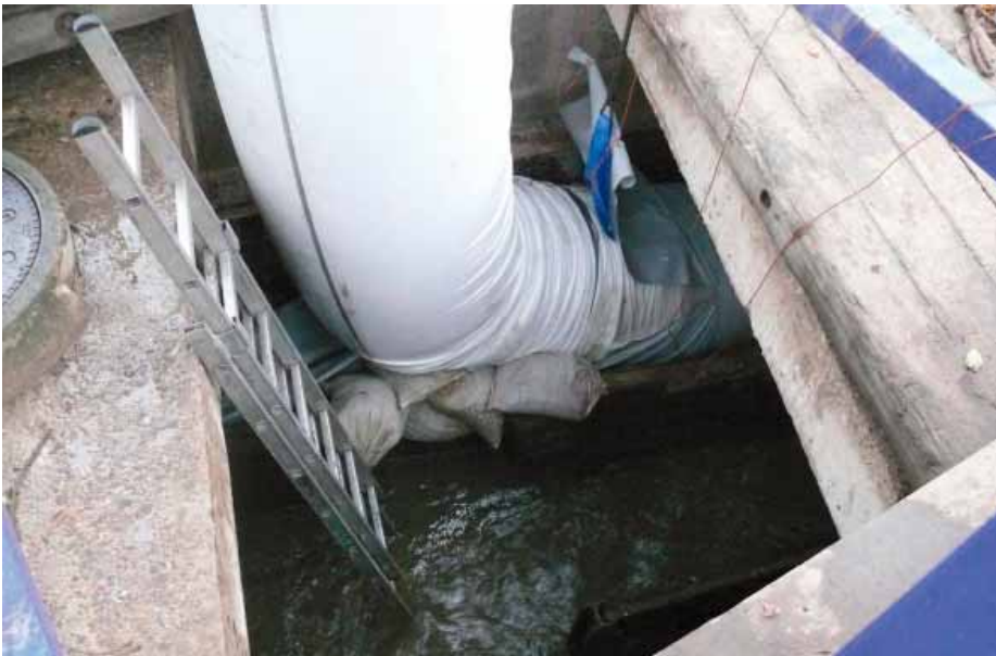
Per Wasserdruck formschlüssig expandierter Liner im Übergang zum Dükerrohr.
