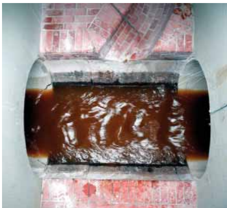
Wieder im Betrieb: Der Hauptsammler unmittelbar oberhalb des Dükers, in beiden Haltungen ausgekleidet mit Schlauchlinern.
