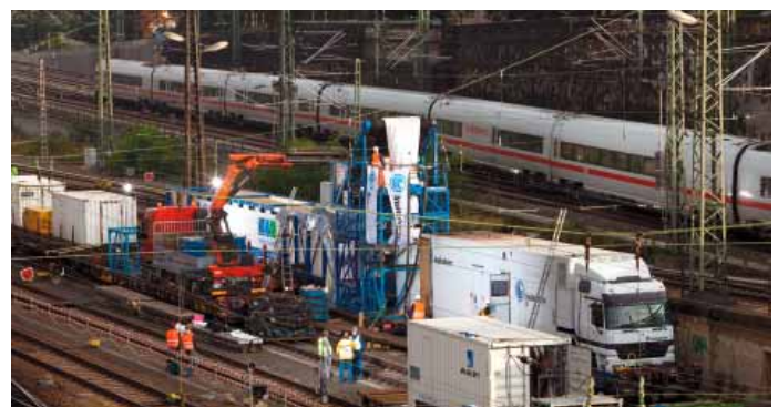
Material, Maschinen und Geräte mussten Ausnahmslos über Gleise zum Baufeld transportiert werden.
