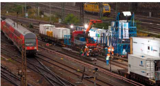
Der zu sanierende Kanalabschnitt verläuft in voller Länge unter den Gleisen im zentralen Zufahrtbereich des Dresdener Hauptbahnhofes.
