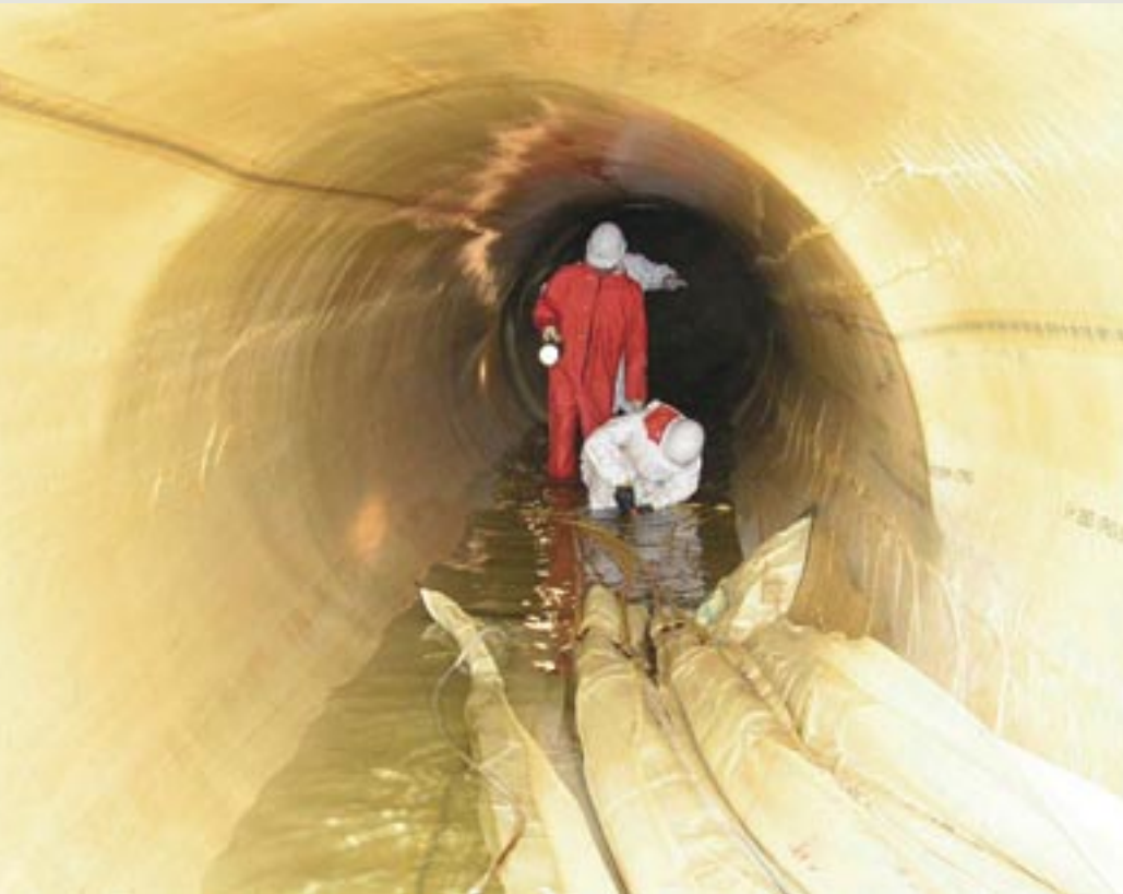
Rückbau der Heizschläuche im fertigen Liner.
