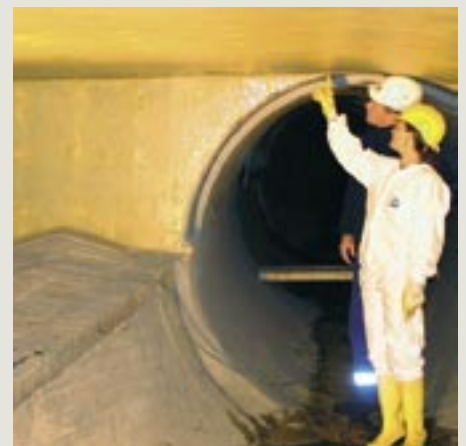
Anbindung und Auskleidung der Bauwerke mit GFK
