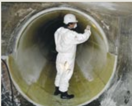
Der zweite Liner ist fertig eingebaut.
