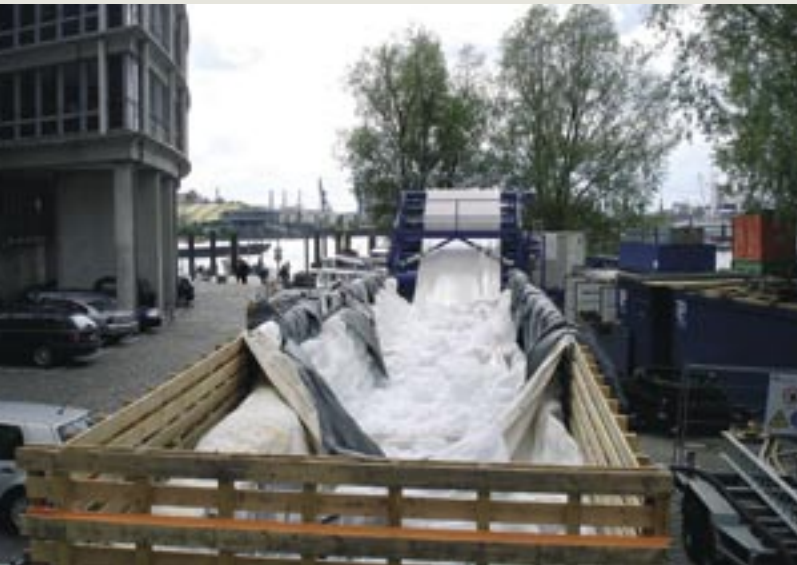
Einzug des ersten Schlauchliners.
