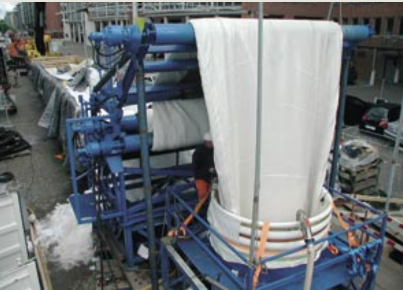
Einbauprozess über Laufband und Gerüst.
