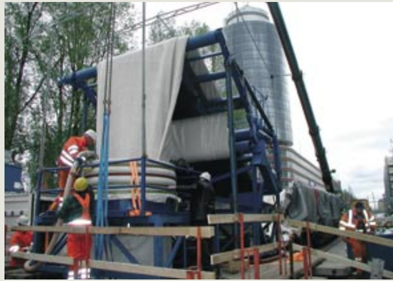
Inversion des zweiten Liners mit Wasserdruck.
