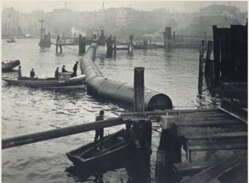
Neubau des Niederhafendükers ab 1890.
