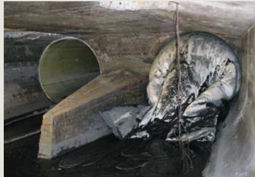
Abkühlphase des Liners in der Weströhre.
