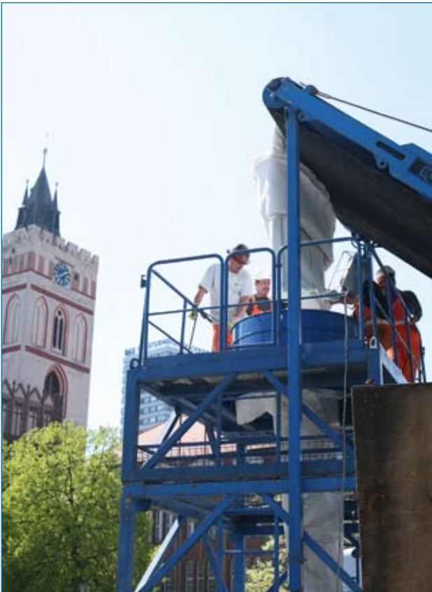
Insituform-typischer Inversionsturm
