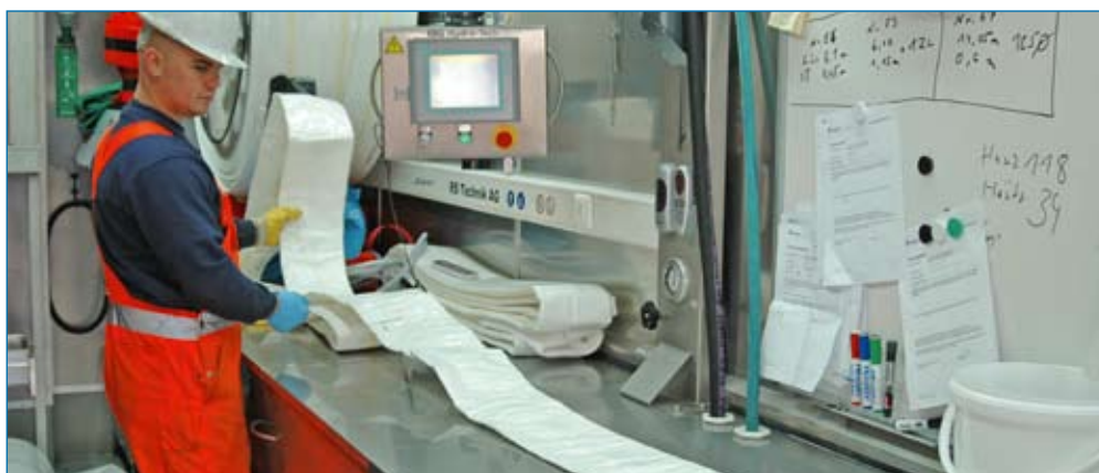
Imprägnierung des Liners vor Ort in der mobilen Tränkungsanlage
