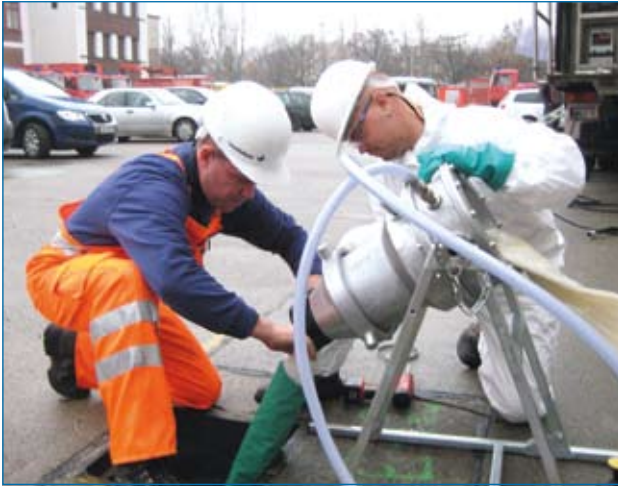
Vorbereitung der Inversion des Liners
