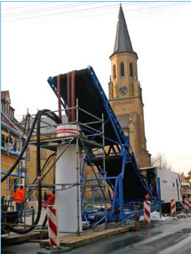
Einbau eines Insituform Druckschlauches
