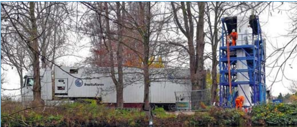
Inversion des Insituform Druckschlauches
