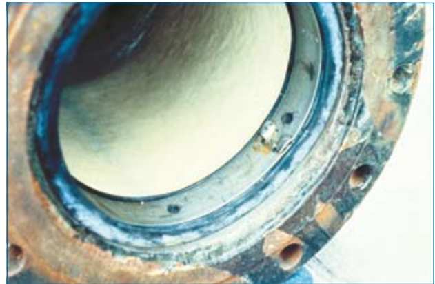
Endeinbindung des Insituform Druckschlauches
