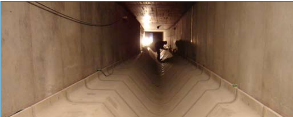
Auskleidung des Sohlbereichs mit Polymerbeton-Elementen
