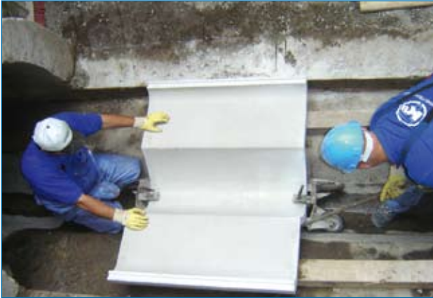
Einfahren des Polymerbeton-Sohlschalenelements
