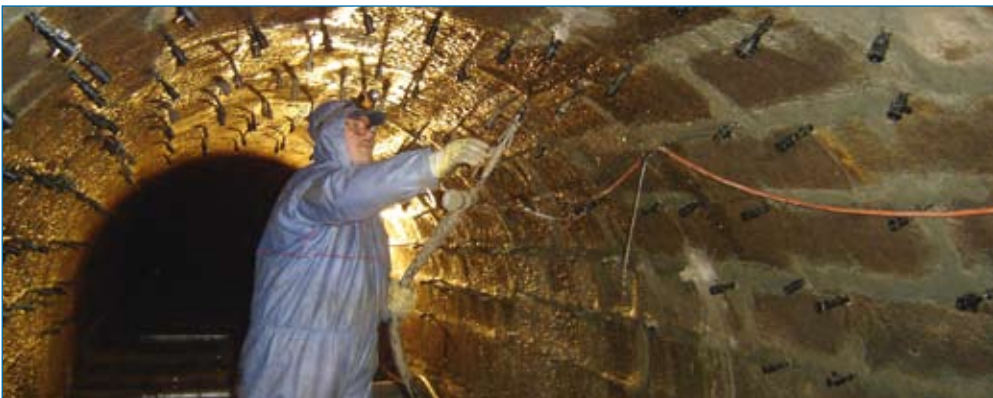
Mineralische Verpressung der Kanalwände
