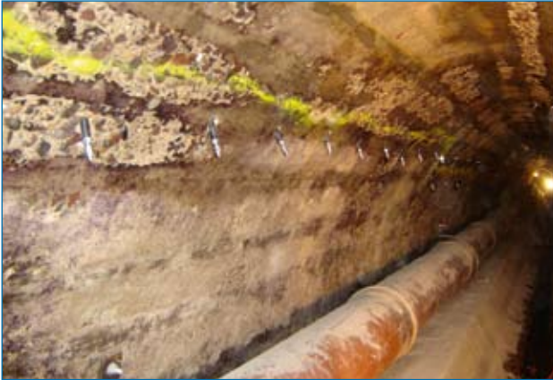
Risssanierung mit PU-Harz
