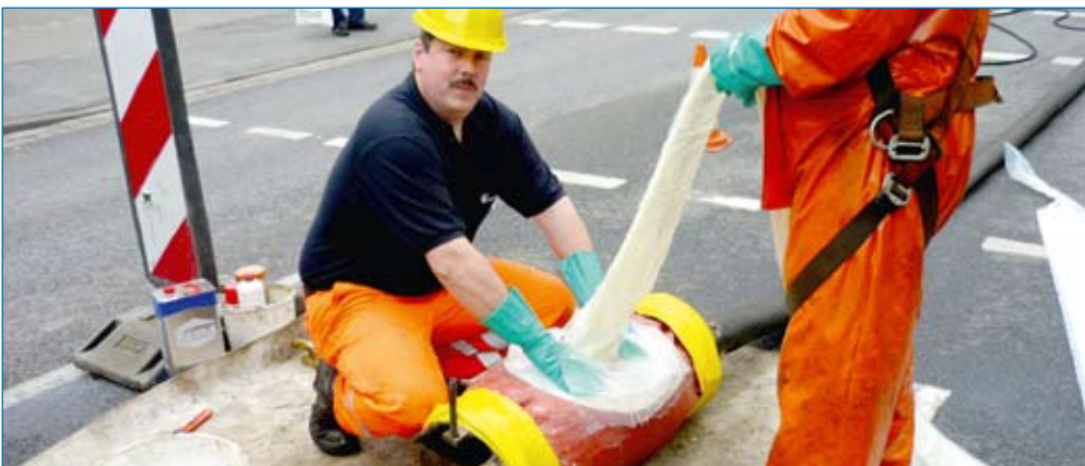
Vormontage des imprägnierten Liners auf das Einbaumodul
