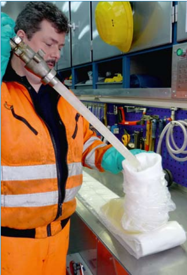
Einfüllen des Harzes vor Imprägnierungsbeginn
