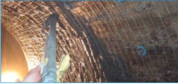
Beschichtung im Nassspritzverfahren
