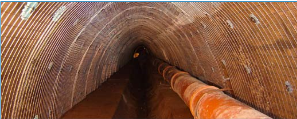
Sanierungsabschnitt im Bauzustand mit innenliegender Wasserhaltung
