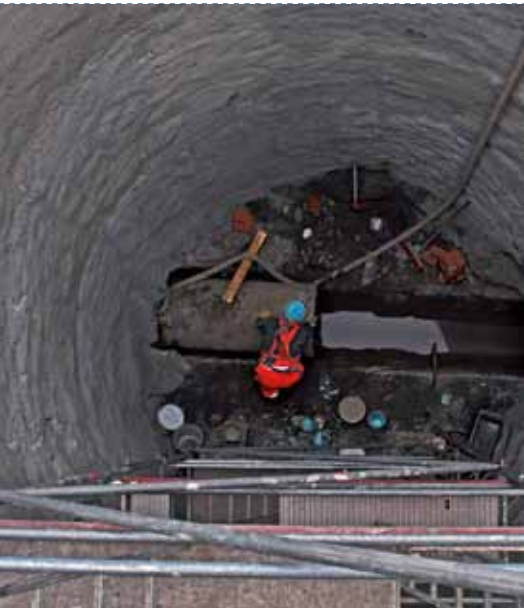
9,50 Meter tief war die Baugrube, über die in Asperg ein neuer Abwassersammler verlegt wurde.
