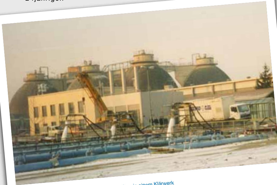
„Drei mit einem Mal“: Paralleler Einbau der Liner in einem Klärwerk
