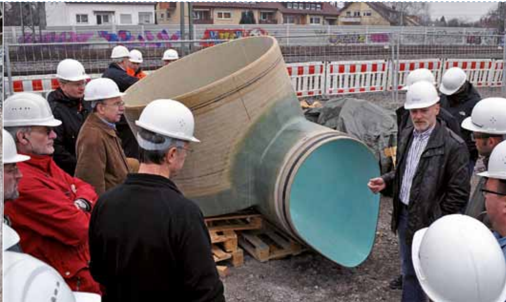
Maßfertigung: Schachtanschluss-Bauwerk aus GFK mit Tangentialeinstieg DN 1500, auf den ein 8 Meter hoher GFK-Schacht aufgesetzt wurde.
