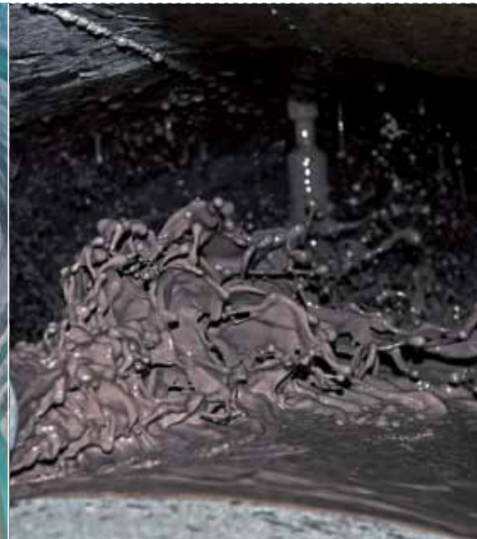
Verdämmen „live“: Mit hohem Druck strömt der Flüssigzement in den Ringraum.
