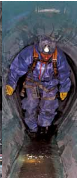
Insituform-Mitarbeiter auf dem Weg zum Einsatz im neuen - aus AMIREN- Wickelrohren gefertigten - Kanal.
