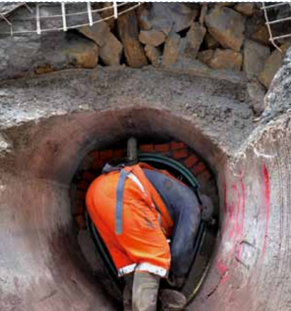
Nach abschnittsweiser Abmauerung des Ringraums wurde der GFK-Kanal durch Verfüllung mit 190 m 3 Dämmern in seiner Lage stabilisiert.
