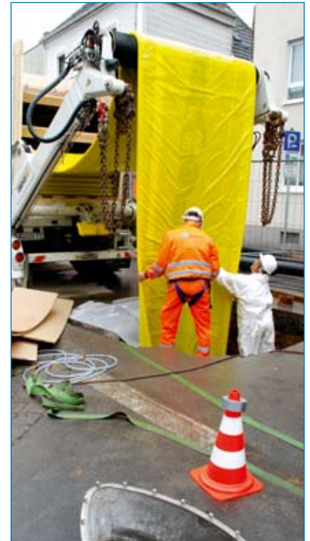
Montage-Innovation von Insituform: Dieser für den Schlauchlinertransport und -einzug umgerüstete Wechselmulden-Transporter.
