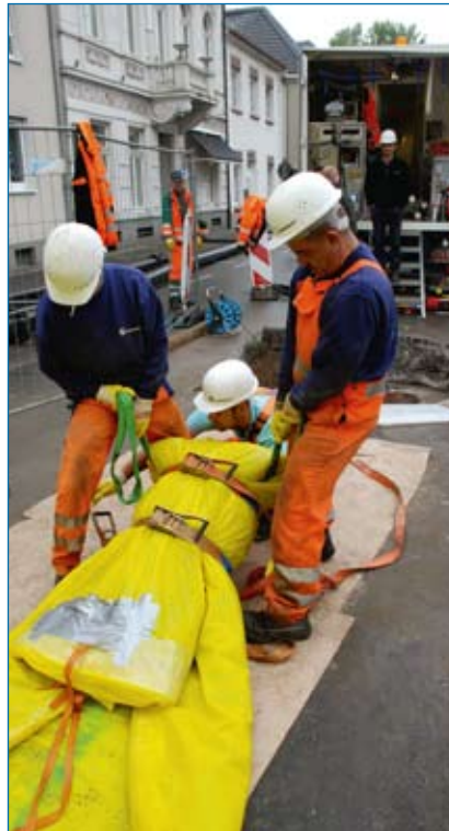
Der Zugkopf des 7,8 Tonnen schweren Liners wird vorbereitet.
