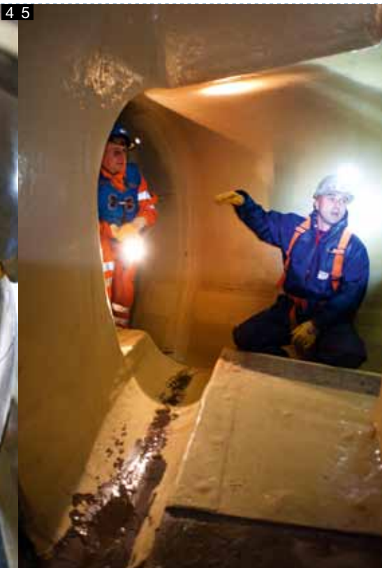
Bild 1: Mittels Kran werden die GFK-Elemente abgeladen Bild 2: Transport der Rohrstücke mit dem Rohrshuttle an den Einbauort Bild 3: Verbindung der Muffen mit UP-GF Handlaminat Bild 4: Einpassung GFK-Rohr zur Aufnahme durch den Rohrshuttle Bild 5: Anbindung der Seitenzuläufe mit UP-GF Handlaminat Bild 6: Fertig angebundener Seitenzulauf Roland Schmid, Fotograf BR, Basel
