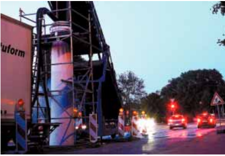
Die Baustelle Mühlenstraße spät abends beim Aushärten des Liners.
