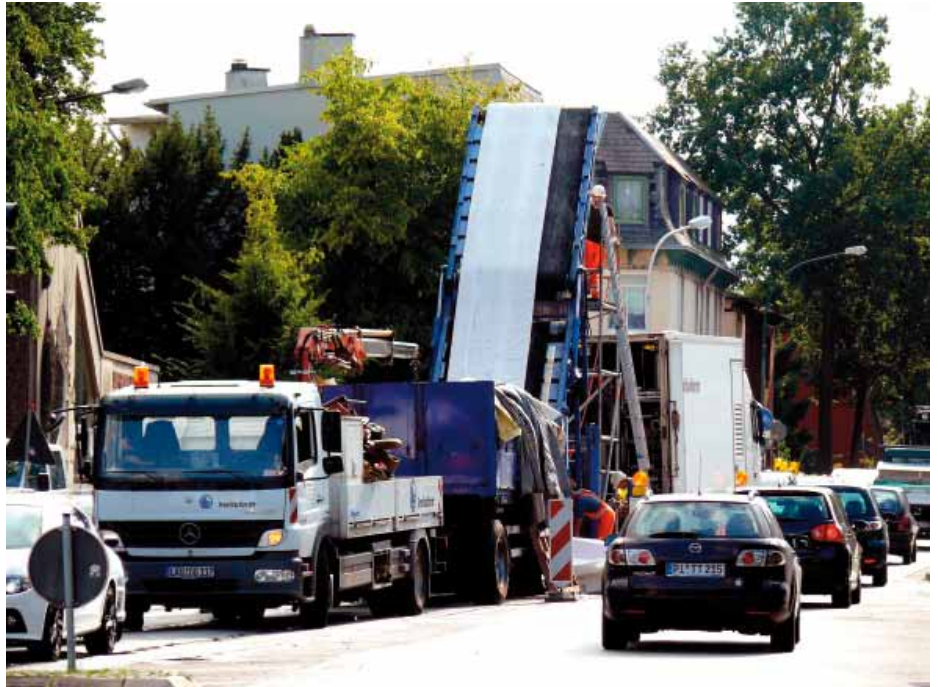
Pneumatische Inversion eines Liners DN 200 im Fasanenweg. Der Liner wurde durch Dampf ausgehärtet.
