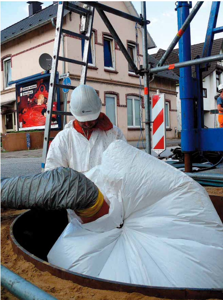
Einblasen eines Kunststoff-Preliners, der den eigentlichen Schlauchliner beim Einbau schützt.
