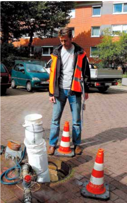
Die Fremdüberwachung der Baustelle beinhaltet nicht nur das Endergebnis des Schlauchlining, sondern auch Einrichtung und Abläufe auf der Baustelle.
