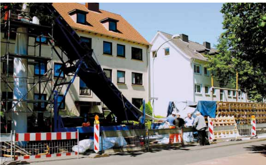
Das „Highlight“ des Pinneberger Sanierungsprogramms 2009: Der 400-Meter Liner, den Insituform in ein Eiprofil DN 600/900 installierte.
