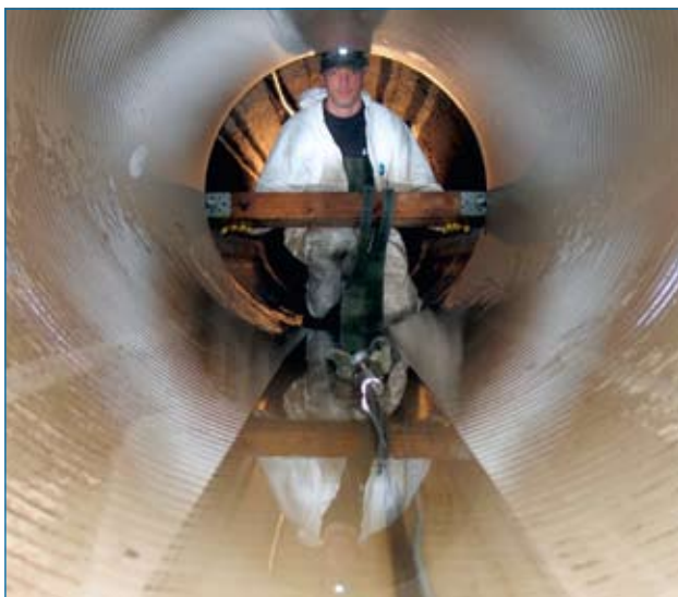
Auch bei Insituform: Renovierung von Abwasserkanälen mit vorgefertigten Rohren
