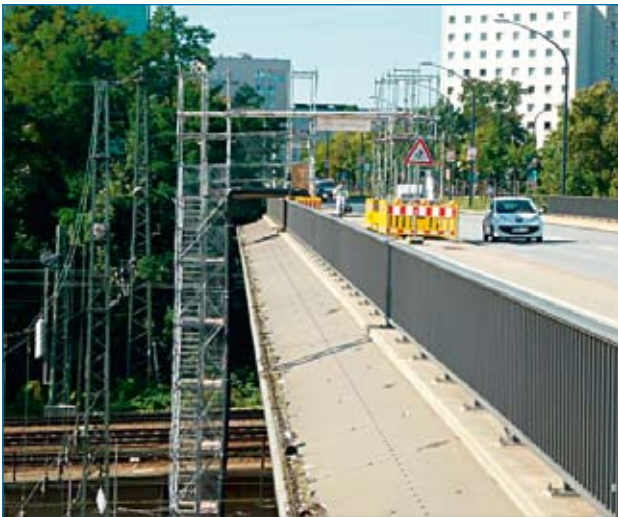
Der 16 m hohe Treppenturm ermöglichte den direkten Zugang auf das Bahngelände.
