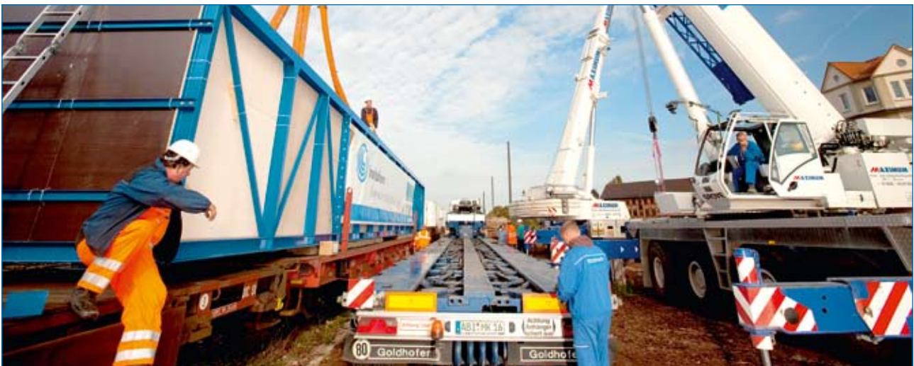
Bahnhof Arnstadt: Verladung des Liners von der Straße auf die Schiene mittels zweier 140-t-Krane
