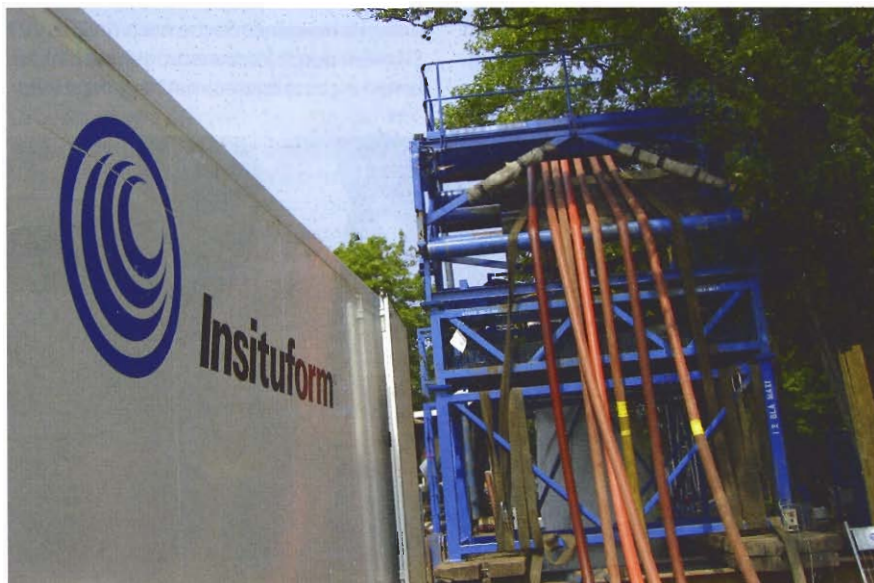
3 Die Baustelle während der Aushärtephase
