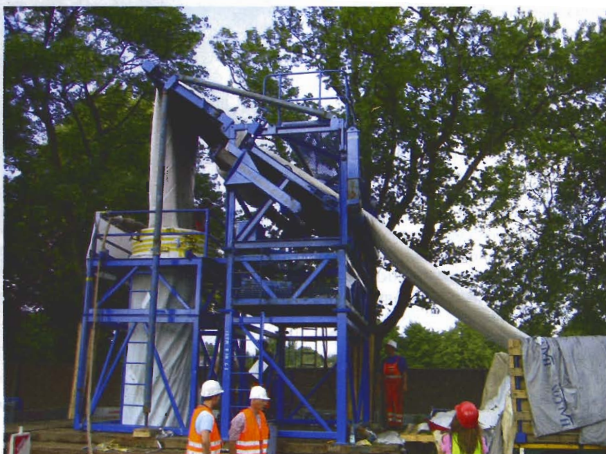
2 Einbau des Schlauchliners
