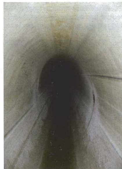
4 Blick in den sanierten Kanal
