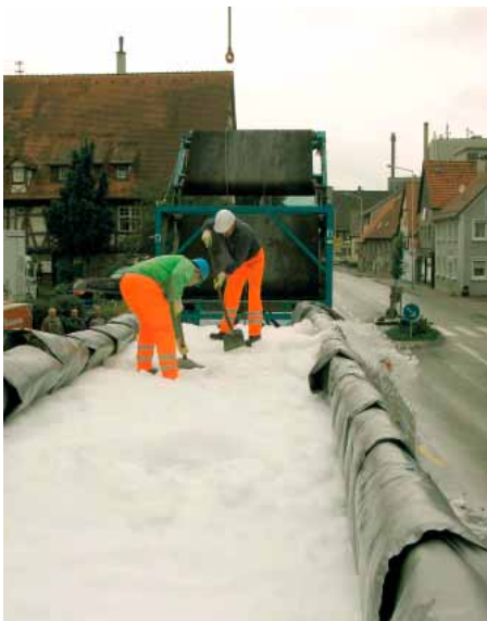
Mit Eis gekühlt wurde der Schlauch „just in time“ mit einem Spezialtiefloader auf die Baustelle gebracht.
