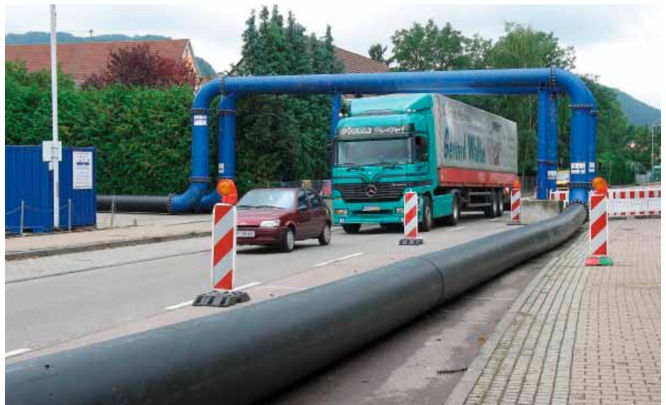
Um den Kanal zuverlässig wasserfrei zu halten, wurde eine sehr leistungsstarke Wasserhaltung aufgebaut.
