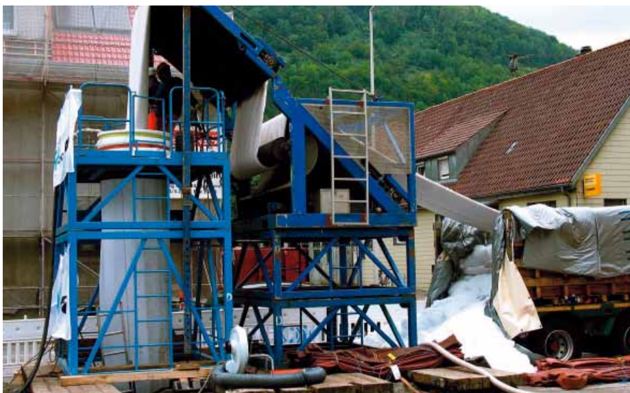
Inversion des 270 Meter langen und 42 Tonnen schweren Liners.
