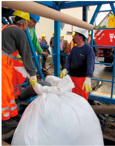
Als Pre-Liner wurde ein 0,3 Millimeter starker PE-Schlauch in den Kanal eingeblasen.
