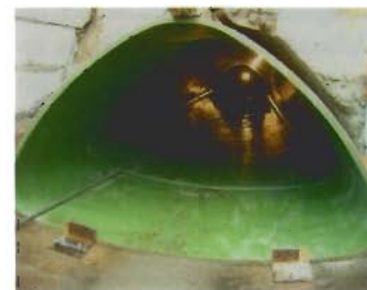
Der künftige Abschlagskanal wurde im Reliningverfahren mit 1 m bis 3 m langen Maulprofil-Kurzrohren ausgekleidet.
