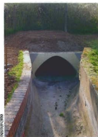
Am Auslass des sanierten Abschlagskanals wird die geringe Überdeckung des Bauwerks deutlich, die für die Relining-Sanierungslösung ausschlaggebend war.
