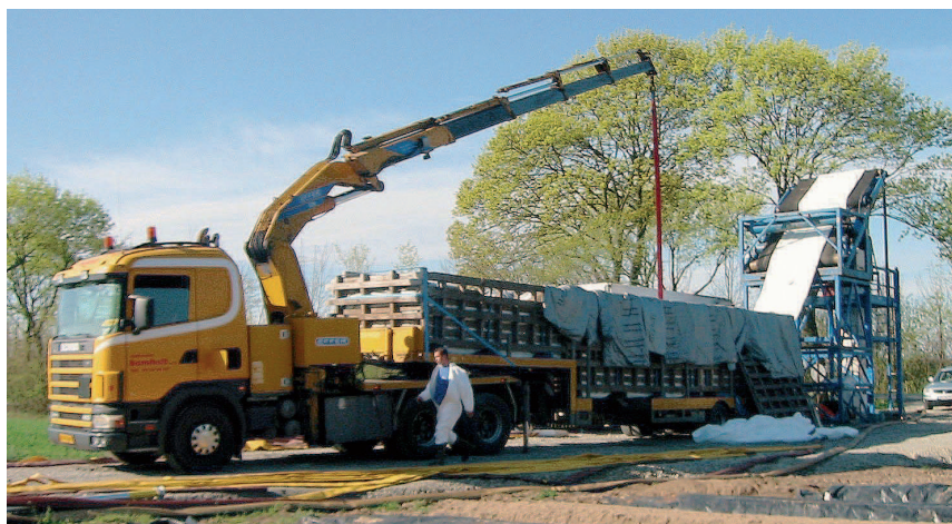
Abb. 1 Bis zu 60 Tonnen schwere Linertransporte mussten über eigens hierfür befestigte Feldwege an den Ort des Einbaus transportiert werden.
