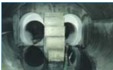
GFK-Schachtsanierung und Einbindung eines Insituform® Schlauchliners DN 2000
