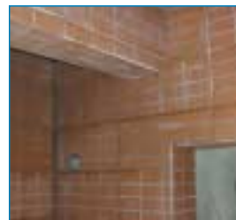
Einbau von Klinkerplatten
