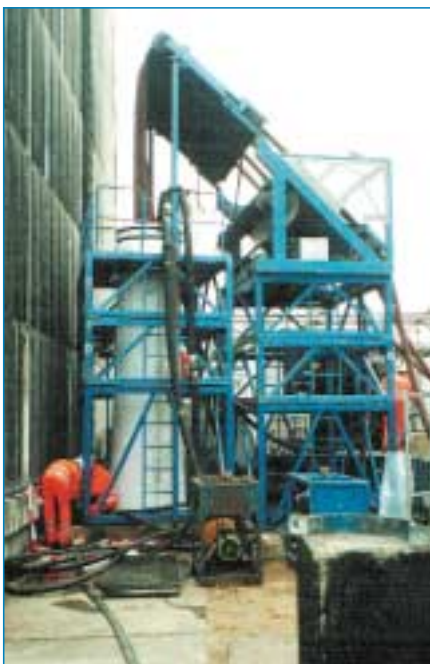
Einbau des Insituform®-Schlauchliners am Industriestandort
