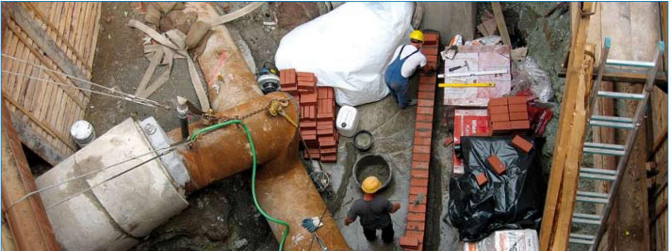
Saubere Lösung: Die Konstruktion der Wasserhaltung in der Baugrube für das neue Schachtbauwerk.
