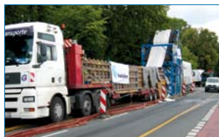
Direkt vom Tieflader wird der Schlauch mit einem Gesamtgewicht von rund 22 Tonnen in den 210 Meter langen Haltungsabschnitt invertiert.
