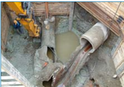
Freigelegt: Das Kreuzungsbauwerk in 9 Meter Tiefe.
