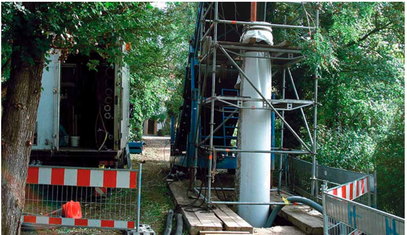
Am Schlauchlining-Projekt Speyer war die gesamte Palette der Insituform-Verfahrenstechnik beteiligt: Neben der klassischen Installation über das typische Förderband...
