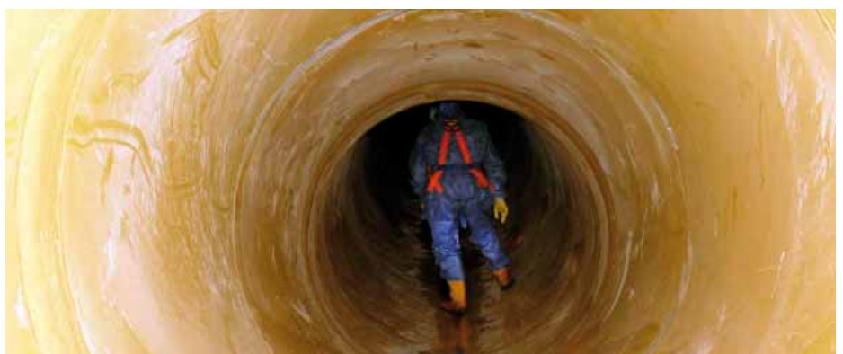
Begehung des Rothebach-Dükers über den absteigenden Dükerast.
