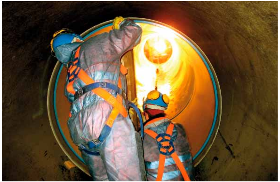
Bauszene aus der Ost-Röhre: Ankoppeln eines GFK-Rohrs per Winde.
