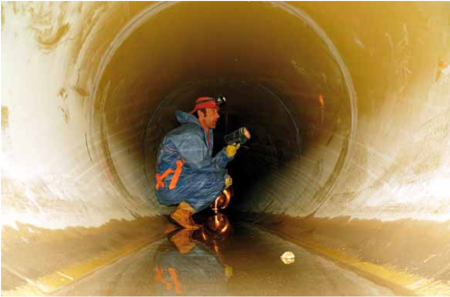
Die neue West-Röhre DN 1600 des Rothebach-Dükers.
