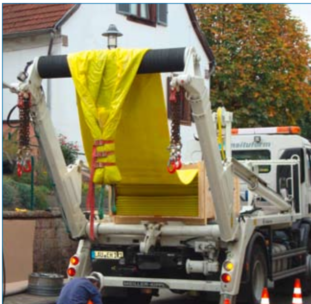
Vorbereitende Arbeiten für den Einbau
