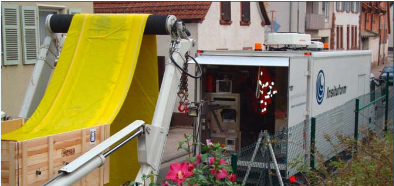
Einbau UV-Liner DN 800
