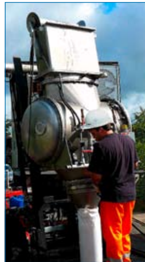
Links: Linerinstallation unter extremen Verkehrsbedingungen: An der Mühlenstraße ging es tagsüber sehr eng zu. | Rechts: Die Fremdüberwachung der Baustelle beinhaltet nicht nur das Endergebnis des Schlauch-lining, sondern auch Einrichtung und Abläufe auf der Baustelle.
