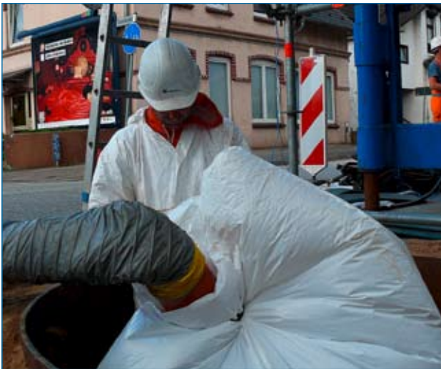
Einblasen eines Kunststoff-Preliners, der den eigentlichen Schlauchliner beim Einbau schützt.
