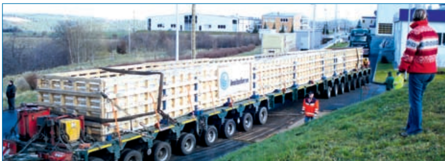
Projektplanung: Sondertransport eines Inliners auf die Baustelle mit 205t Gesamtgewicht, 24 Achsen, 52m Länge
