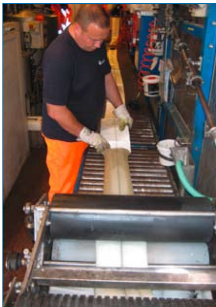
Schnellhärter-Imprägnierung: Imprägnierung des Liners vor Ort in der mobilen Tränkungsanlage
