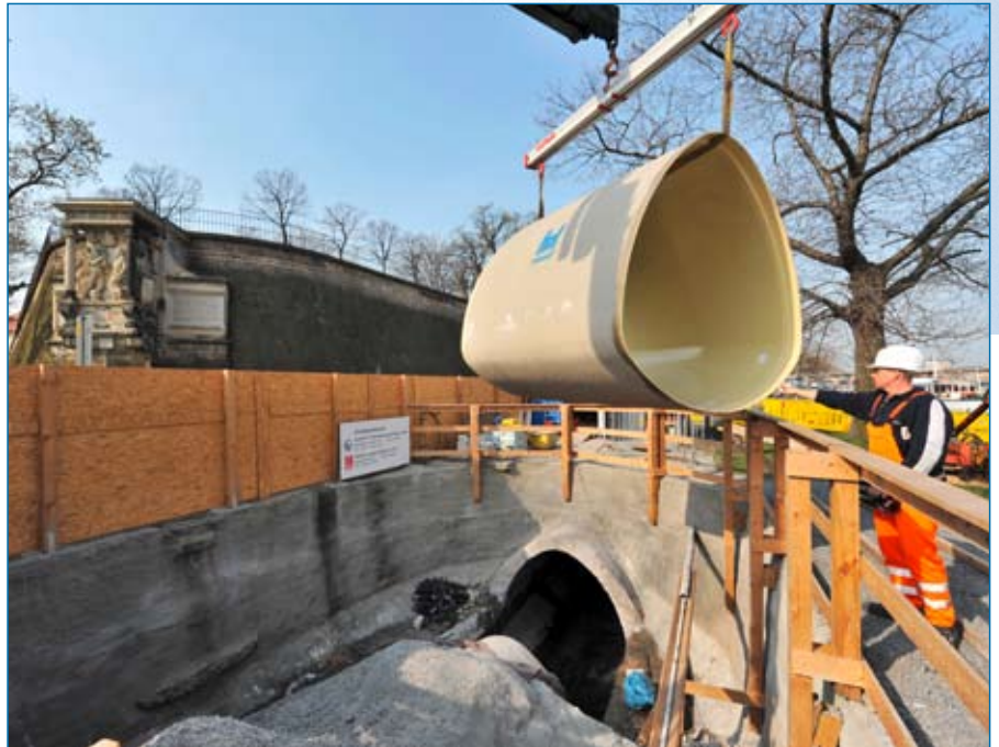
Links: Vorbereitung der GFK-Sonderprofile für die Verlegung | Rechts: Hinablassen eines GFK-Profils in die Baugrube, Fotoquelle: HOBAS Rohre GmbH
