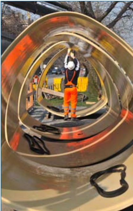
Links: Vorbereitung der GFK-Sonderprofile für die Verlegung | Rechts: Hinablassen eines GFK-Profils in die Baugrube, Fotoquelle: HOBAS Rohre GmbH
