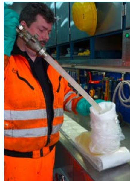
FAS: Einfüllen des Harzes vor Imprägnierbeginn
