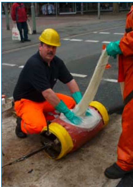
FAS: Vormontage des imprägnierten Liners auf das Einbaumodul
