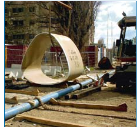
Bild 4: Einbau von GfK-Sonderprofilen der Fa. HOBAS BV: Dresden, Ostraufer.
