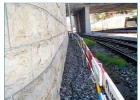
Foto oben: Tiefbauarbeiten für die GFK-Einbaugrube Foto unten: Beengte Verhältnisse für die Schachtzugänge
