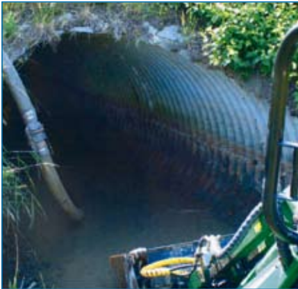
Bild 2: Sanierung eines Wellstahldurchlasses mit Hilfe verdämmter GfK-Rohre.
