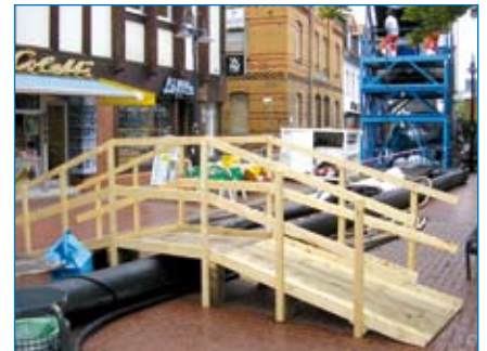
Sicherheitsvorkehrungen und Sauberkeit der Baustelle
