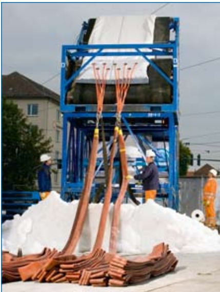
Förderband für den schonenden und gleichmäßigen Linereinbau
