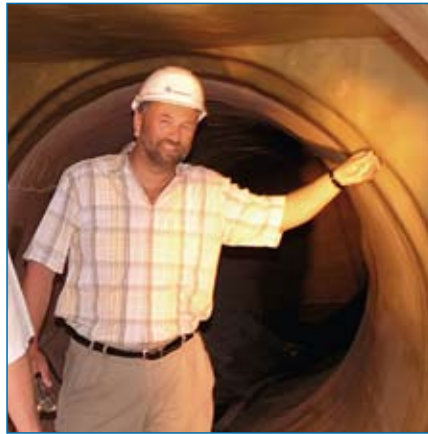
Herr Jürgen Zinnecker bei der Abnahme einer Schachtsanierung
