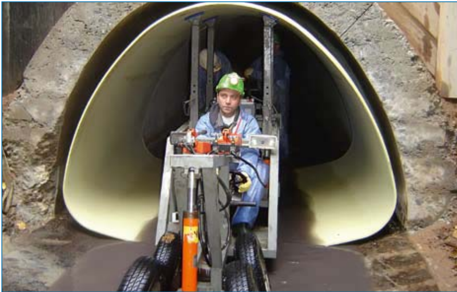
Freiberg Münzbachsammler: Aufnahme der GFK-Rohre mittels Transportwagen zur Platzierung im Kanal
