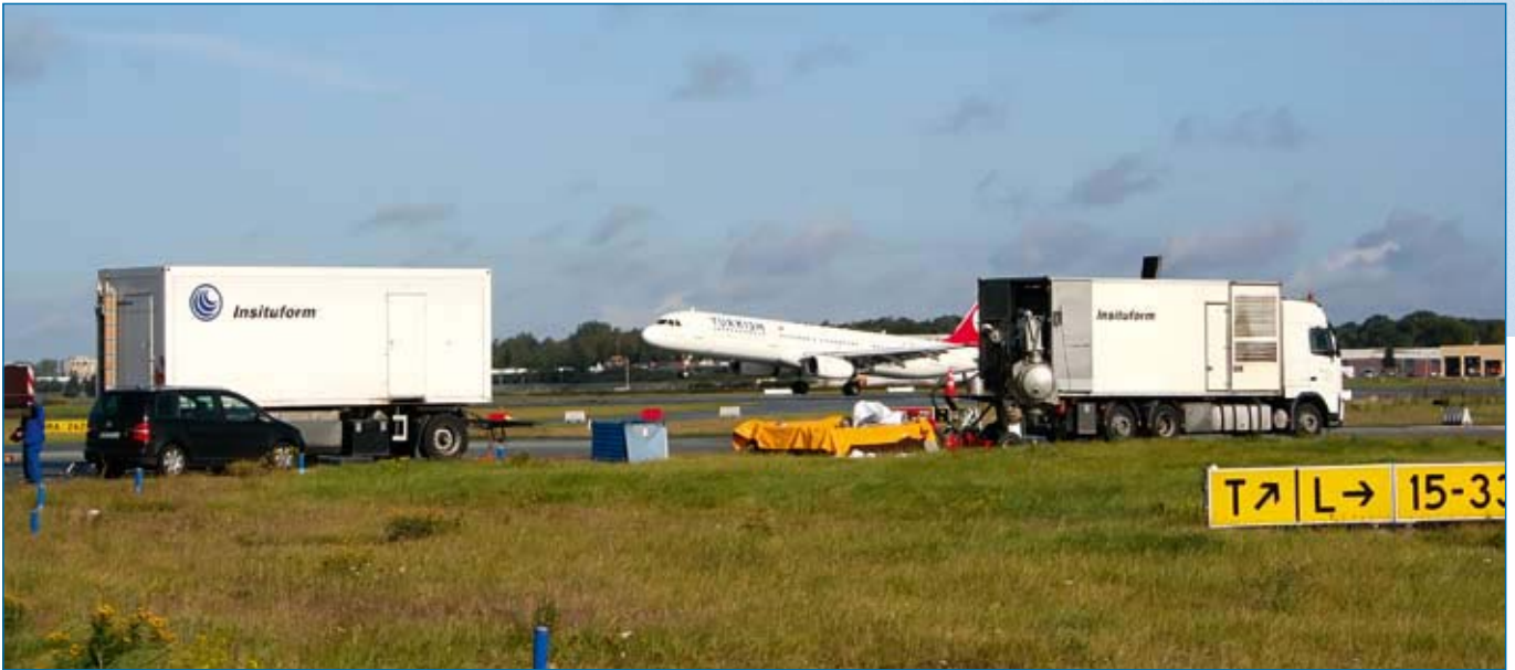
An einigen Stellen war es aus sicherheitstechnischen Gründen untersagt, ein Inversionsgerüst aufzustellen. Dort wurde mit einer Chip Unit und dem Dampfhärteverfahren gearbeitet.
