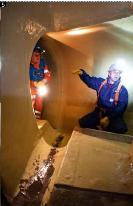
Bild 1: Mittels Kran werden die GFK-Elemente abgeladen Bild 2: Transport der Rohrstücke mit dem Rohrshuttle an den Einbauort Bild 3: Verbindung der Muffen mit UP-GF Handlaminat Bild 4: Einpassung GFK-Rohr zur Aufnahme durch den Rohrshuttle Bild 5: Anbindung der Seitenzuläufe mit UP-GF Handlaminat Bild 6: Fertig angebundener Seitenzulauf Roland Schmid, Fotograf BR, Basel
